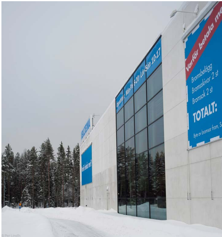
Figur 1. Fasadelement på Biltema i Gävle är försedda med titandioxid. Notera att de nedersta tre elementen är behandlade med klotterskydd och därför har en annorlunda nyans. Foto Per Lindh.
